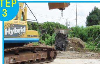
③「瞬作」を吊り下げ移動させる
