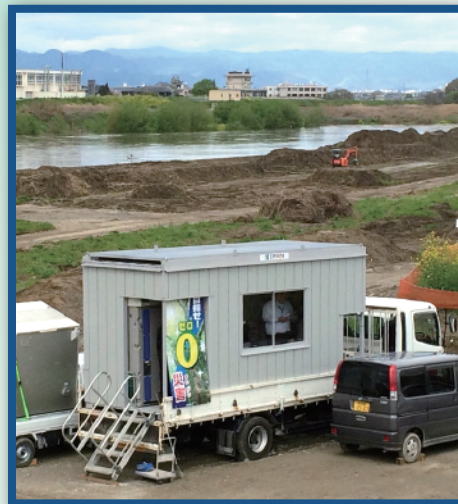
河川工事での使用例
